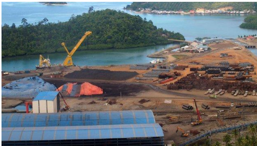
Gambar : Aktivitas Pembangunan Smelter Pemurnian Feronicel
